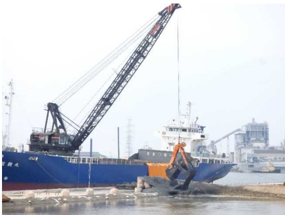
③埋立材の投入状況
