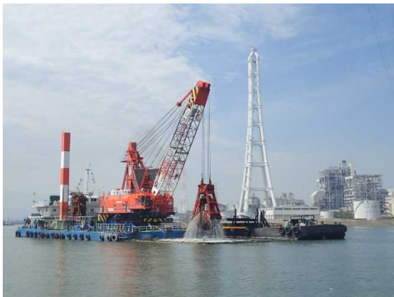
①浚渫状況
