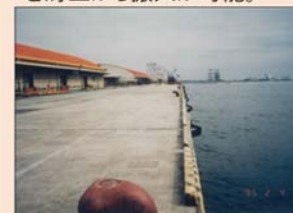
被害が軽微だった耐震強化岸壁【神戸港】
