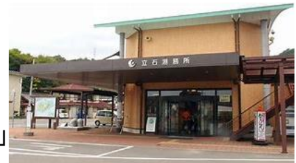
代表施設(上島町) 立石港待合所
