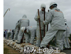
積み土のう工
