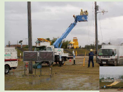
配電線復旧訓練
