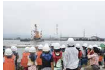
浚渫作業を陸から見学
