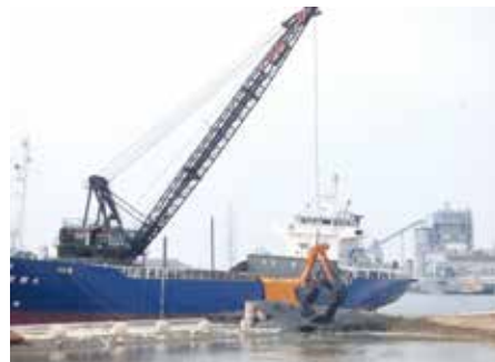
カルシア改質土投入
