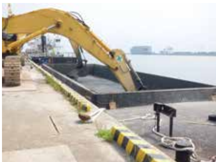
カルシア改質材及び浚渫土混合
