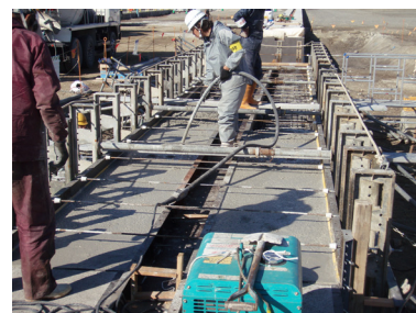
クレーン基礎用コンクリート締固め状況
