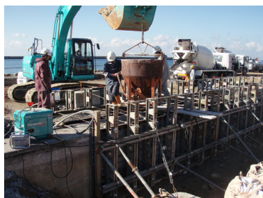
クレーン基礎用コンクリート打設状況
