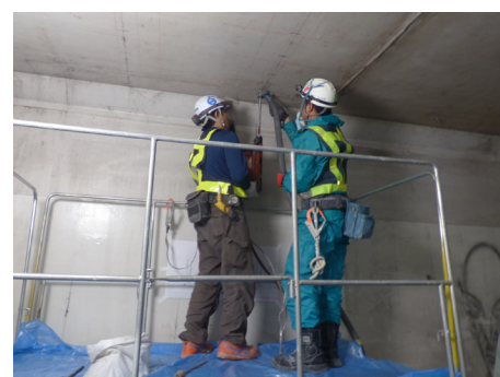
壁面削孔状況
