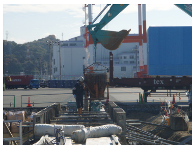
クレーン基礎用コンクリート打設状況
