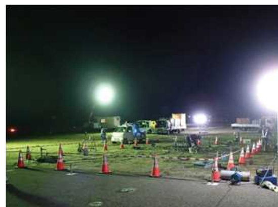
地盤改良の施工状況
