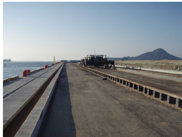
岸壁エプロン部の施工状況
