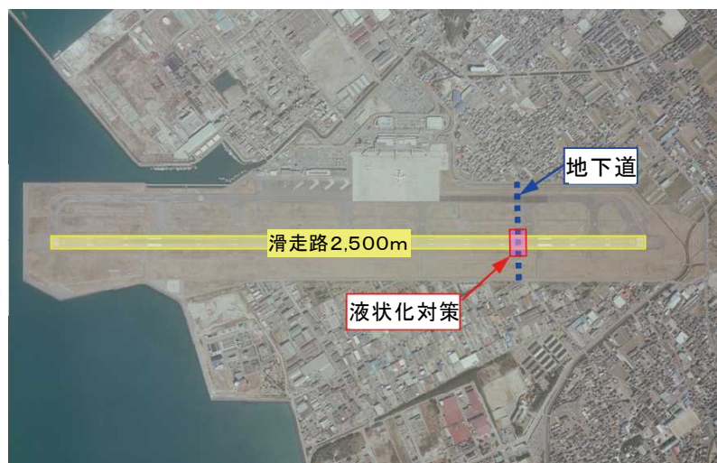
滑走路を横切る地下道
