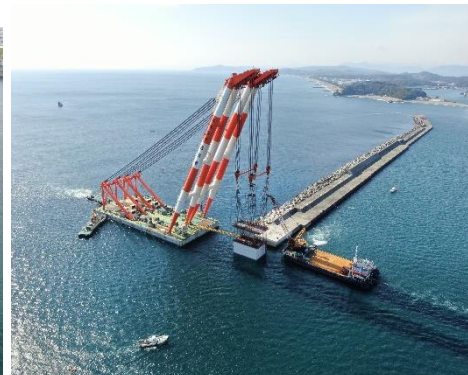
③防波堤(南)(直轄施工) 本體工[ケーソン据付](R5.2撮影)
