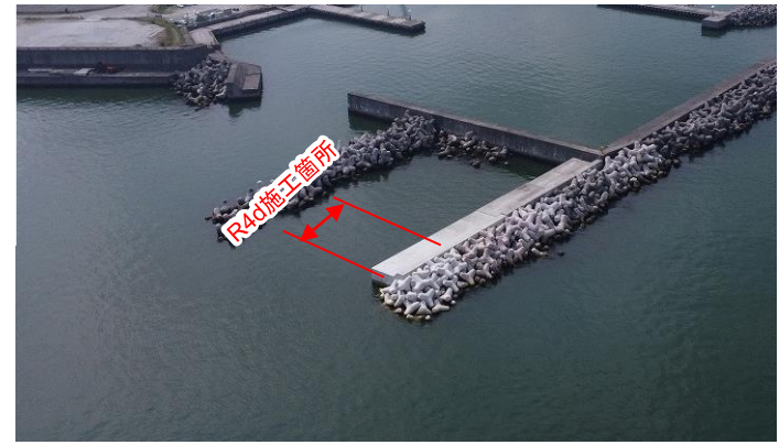
①防波堤(東第一)(直轄施工) 腹付工(R4.8撮影)
