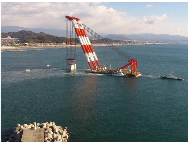
ケーソン曳航作業：午前9時～
