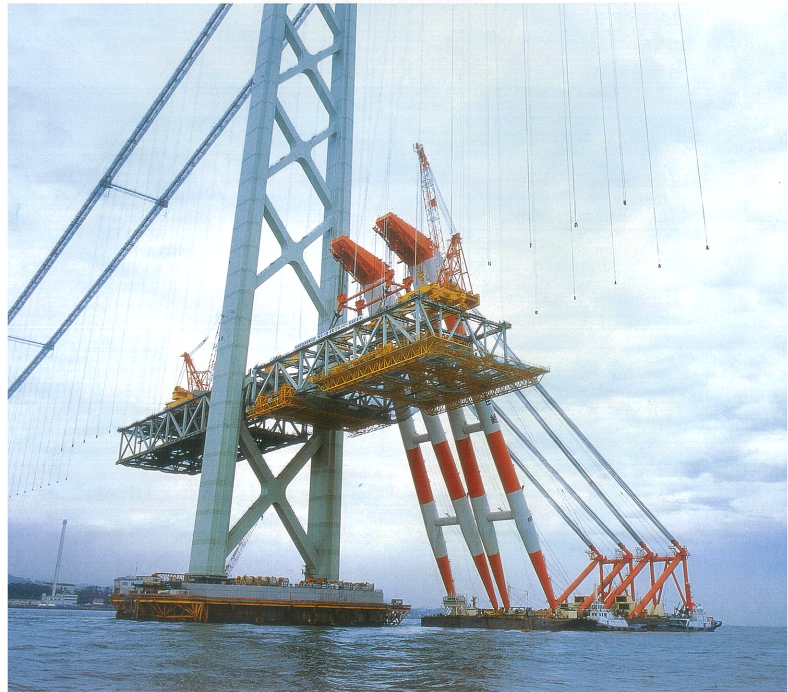
明石海峡大橋補剛桁架設工事
