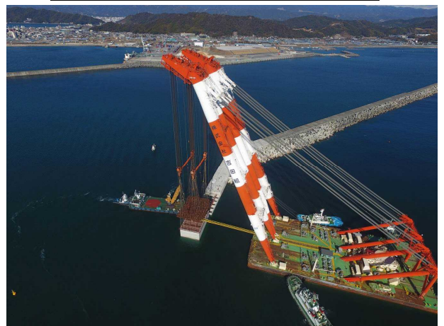
ケーソン据付作業：午前11時～
