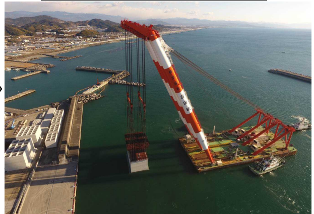
ケーソン吊出作業：午前8時～
