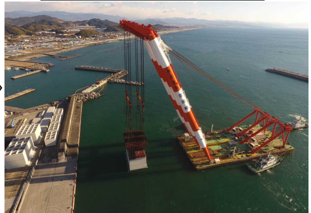
ケーソン吊出作業：午前8時～
