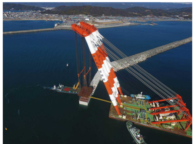
ケーソン据付作業：午前11時～
