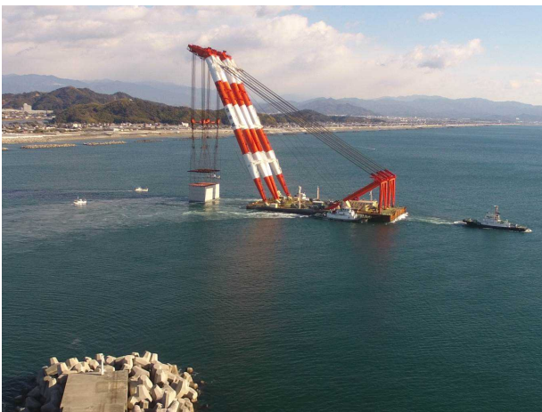
ケーソン曳航作業：午前9時～
