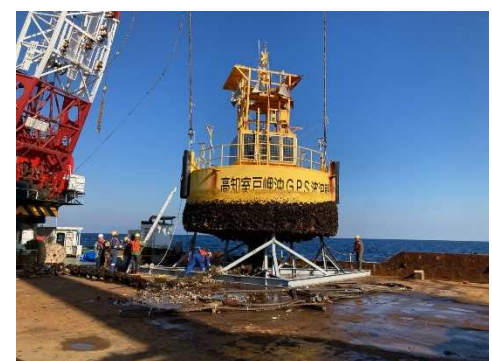
【GPS 波浪計撤去状況（起重機船上）】
