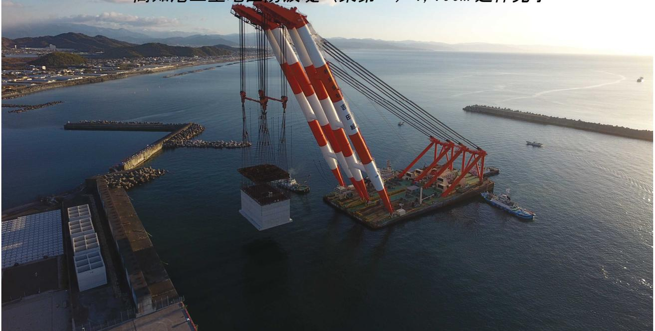
防波堤のケーソン据付工事を以下の日程で実施します。本工事は、国内最大級のクレーン船（高さ約 130m）によるケーソン据付工事です。これで、防波堤（東第一）1,100mの延伸は完了します。
