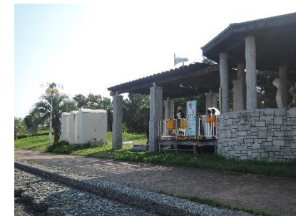
⑬海浜公園（堤防天端）に設置された監視所
