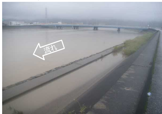
⑤国分川 新国分川橋付近 撮影：H26. 8. 3 17:59
