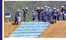
シート張り工 法崩れ対策工
