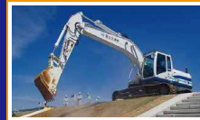
捨て土のう工 決壊対策工
