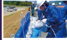
改良積み土のう工 越水対策工
