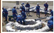
釜段工 漏水対策工
