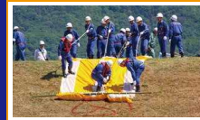
水防マット工
