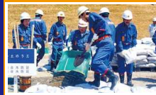
積み土のう工
