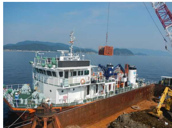
起重機船との連携状況「美讃」(7月18日)
