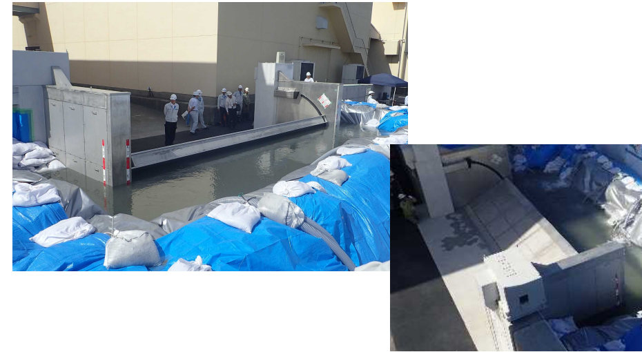
昨年設置したフラップゲートの起動確認の様子
