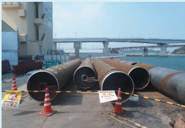
↑ 現場に搬入された鋼管杭(3月)
