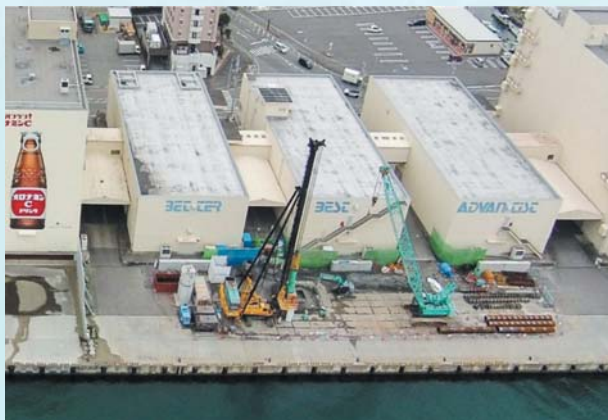
↑ 鋼管杭打設状況(3月)
