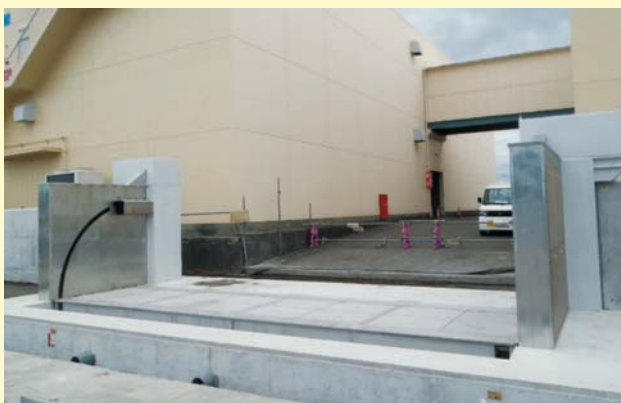
↑ フラップゲート式陸閘(通常時)
