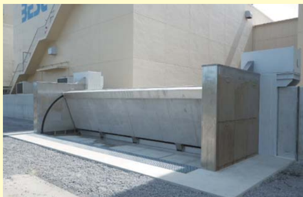
↑ フラップゲート式陸閘(閉鎖時)
