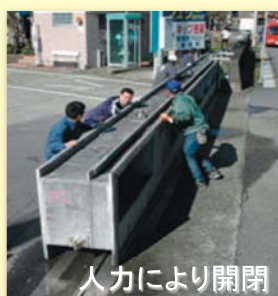
↑ 通常の陸閘(手動)
