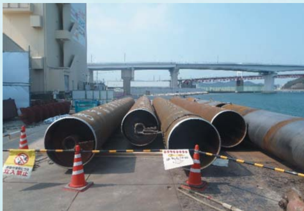
↑ 現場に搬入された鋼管杭(3月)
