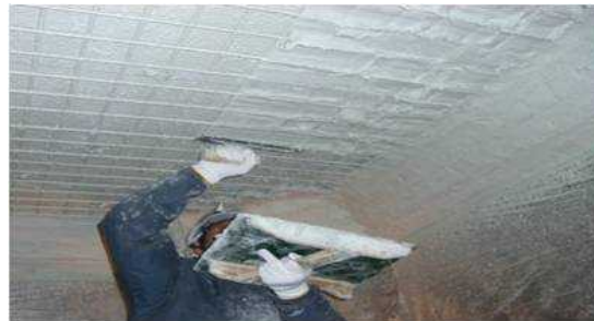
▲ 増厚工法による補強
