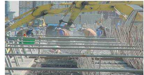
▲ 床版の打ち替え
