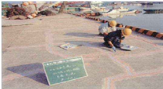
▲ エプロンのひび割れに樹脂を充填
