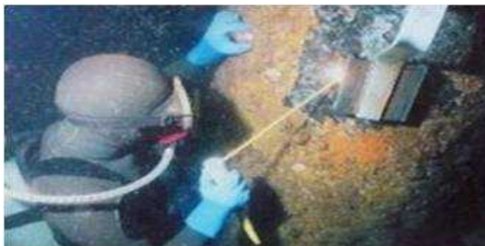
▲ 水中溶接による電気防食の施工
