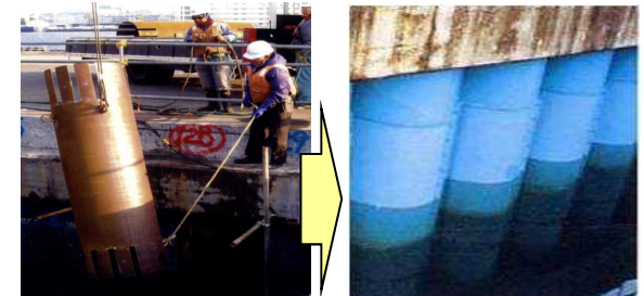
▲ 鋼管杭を鋼板で補強
