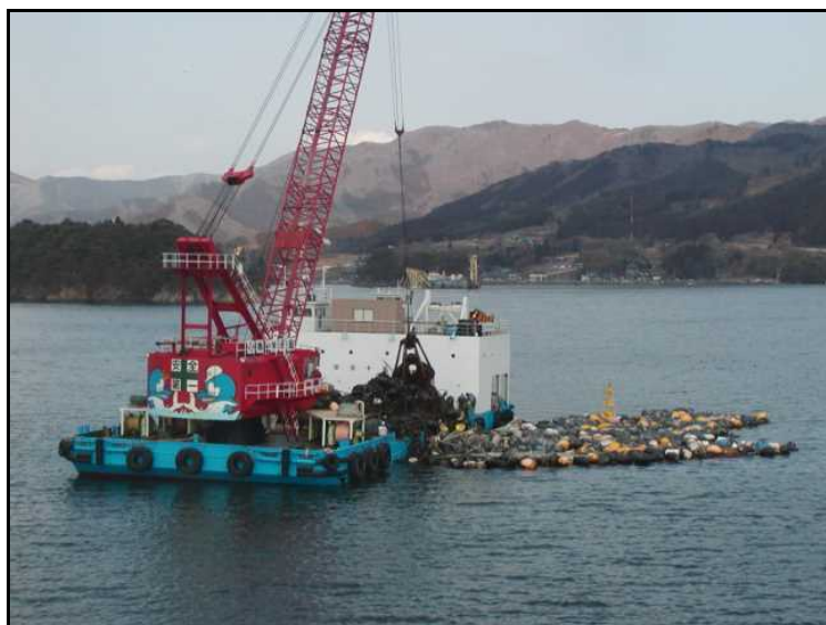
写真. 参-4.4 東日本大震災での大船渡港における浮遊(漂流)物揚収状況
