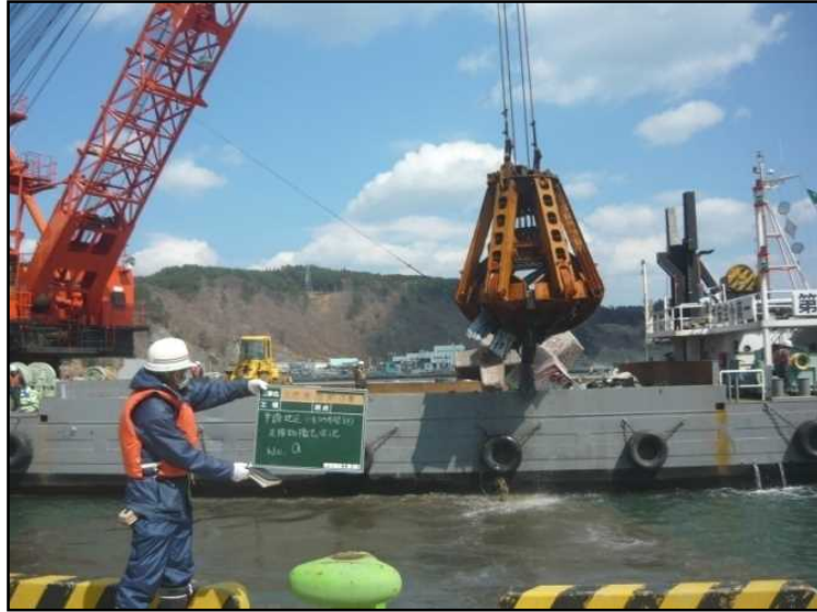
(起重機船によるブロックのバケット揚収)
