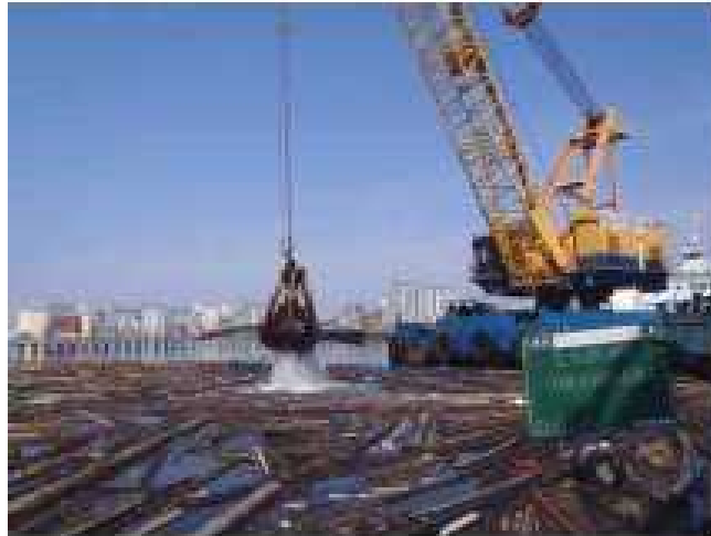
写真 石巻港における浮遊物の揚収状況
