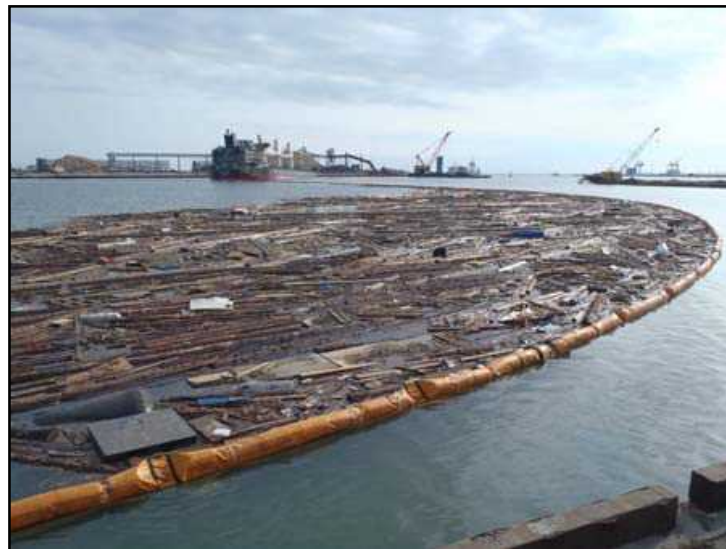
写真. 参-4.2 東日本大震災での石巻港における浮遊(漂流)物囲い込み状況
