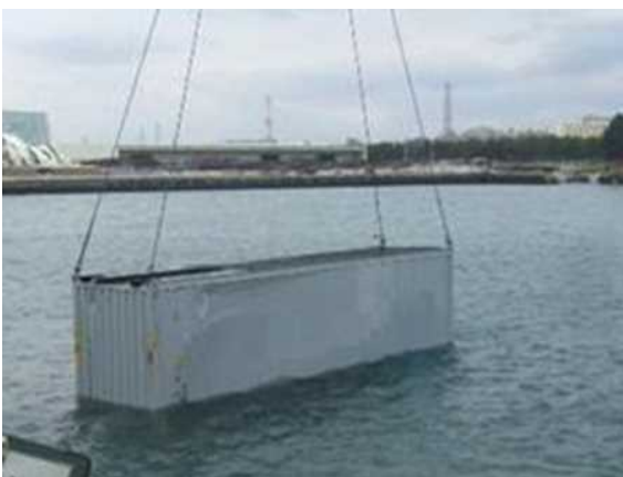
玉掛けによる揚収 (権限の行使を伴わない通常の啓開作業)
