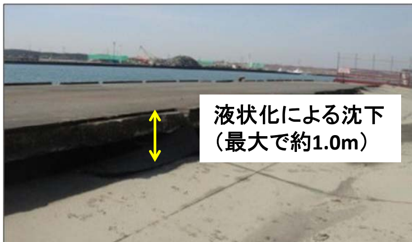
茨城港(日立港区) 第4ふ頭岸壁(-12m)
