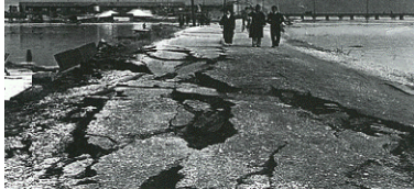
栈橋通りの浸水状況
