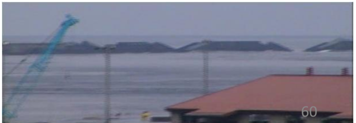
地震発生46分後：津波第1波が引き一部欠けた北堤
