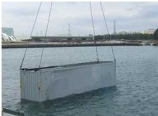
玉掛けによる揚収 (権限の行使を伴わない通常の啓開作業)
