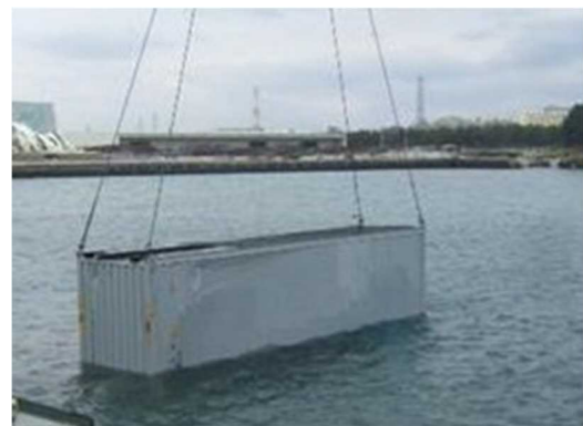
玉掛けによる揚収 (権限の行使を伴わない通常の啓開作業)
