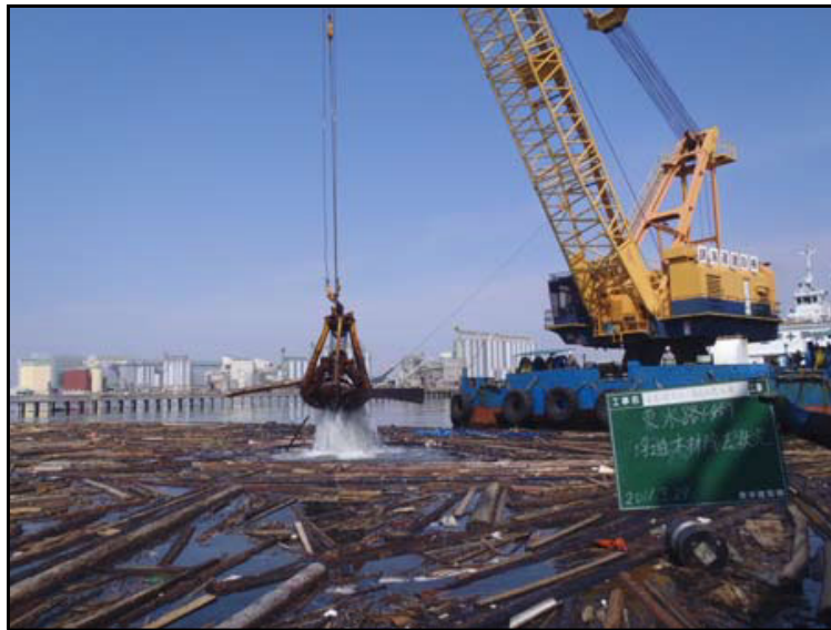
写真一参9(5) 東日本大震災での石巻港における浮遊(漂流)物揚収状況
