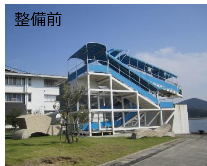
エレベーター無し
