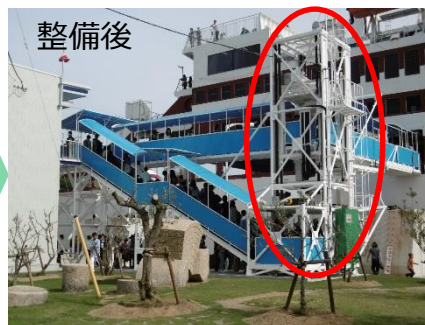
エレベーターを設置
