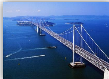
③瀬戸大橋(香川県 坂出市)
