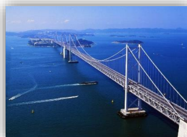
③瀬戸大橋(香川県 坂出市)
